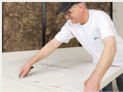
1 Platte bauseits einritzen
