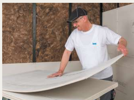
1 Plattenstruktur mechanisch lockern, im Liegen ...
