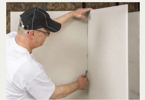
3 Gewebe auf der Rückseite durchtrennen
