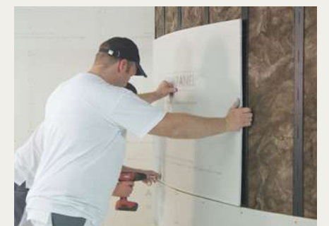
3 An gerundete Unterkonstruktion schrauben
