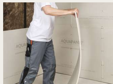
2 ... und im Stehen mit abschließendem Schütteln der Platte.
