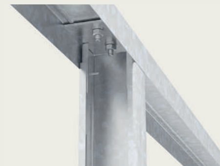
Gleitwinkel mit Bolzenankern befestigen und verschrauben.
