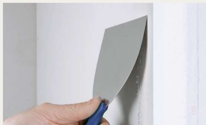
5 Überschüssige Spachtelmasse planeben abziehen, fertig ist die perfekte Ecke
