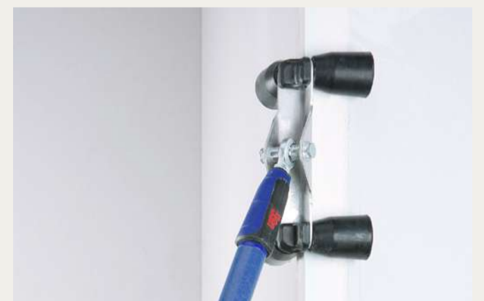
4 Andrücken mit Innen- bzw. Außeneckroller
