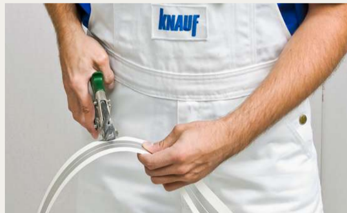
1 Schienen mit Blechschere passend ablängen
